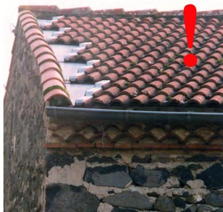
L'emploi de zinguerie est à proscrire ; il est une conséquence de l'utilisation de tuile mécanique, seulement adaptée aux volumes rigoureusement orthogonaux.
