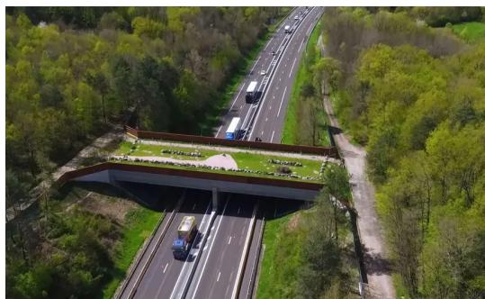
Exemple d’améliorations possibles sur le territoire de Clermont Auvergne Métropole au droit des ouvrages existants - installation d’une banquette petite faune au droit d’un ouvrage hydraulique (à gauche), mise en place d’un accompagnement végétalisé sur ouvrage supérieur peu circulé (à droite)
