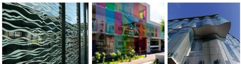
*Exemples de surfaces vitrées diminuant le risque de collision – à gauche, utilisation de marquage, au centre, mise en place de verre coloré, à droite, surface vitrée bombée (Source : Batiadapt, Archiexpo, Wurth Profix)*
