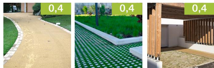
exemples : graviers, dallage de bois, pierres de treillis de pelouse, stabilisé ou terre armée, pavés drainants ou à joints engazonnés, bande de roulement...
