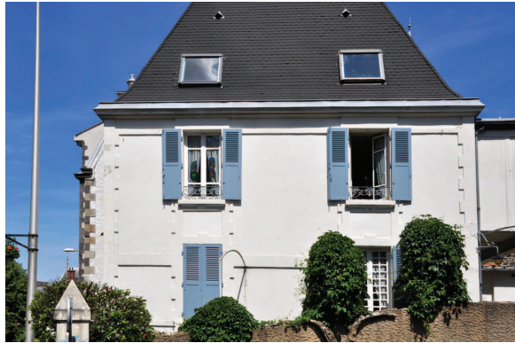
Une villa "blanchie" : la peinture blanche a là aussi écrasé les détails architecturaux, en particulier des chaînes d'angle harpées en saillie.
