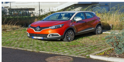
Parking en pavés en béton à jointés enherbés (source parapluie-hydro.com)
