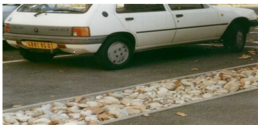
Tranchée drainante (source parapluie-hydro.com)
