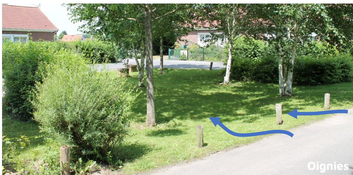
Figure 7 - Espace vert retravaillé en creux, pour gérer les eaux pluviales – Source ADOPTA
