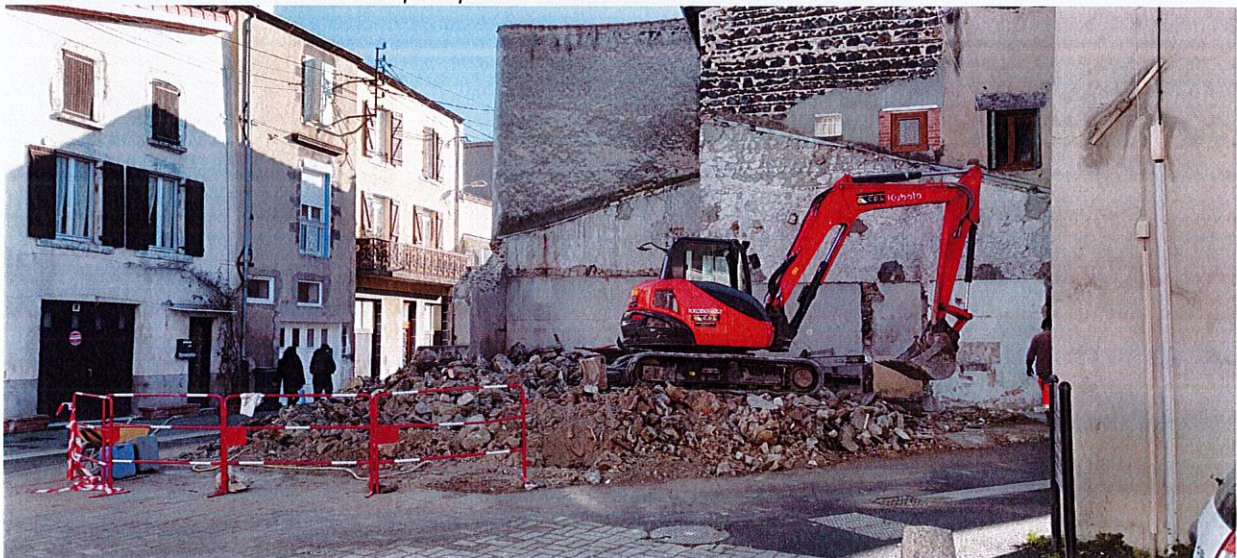
Démolition de l'ancien local des pompiers – Place du Roudet en 2022
